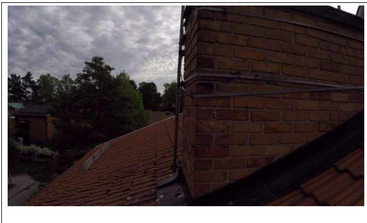
Figur 9, utvändig kontroll skorsten
