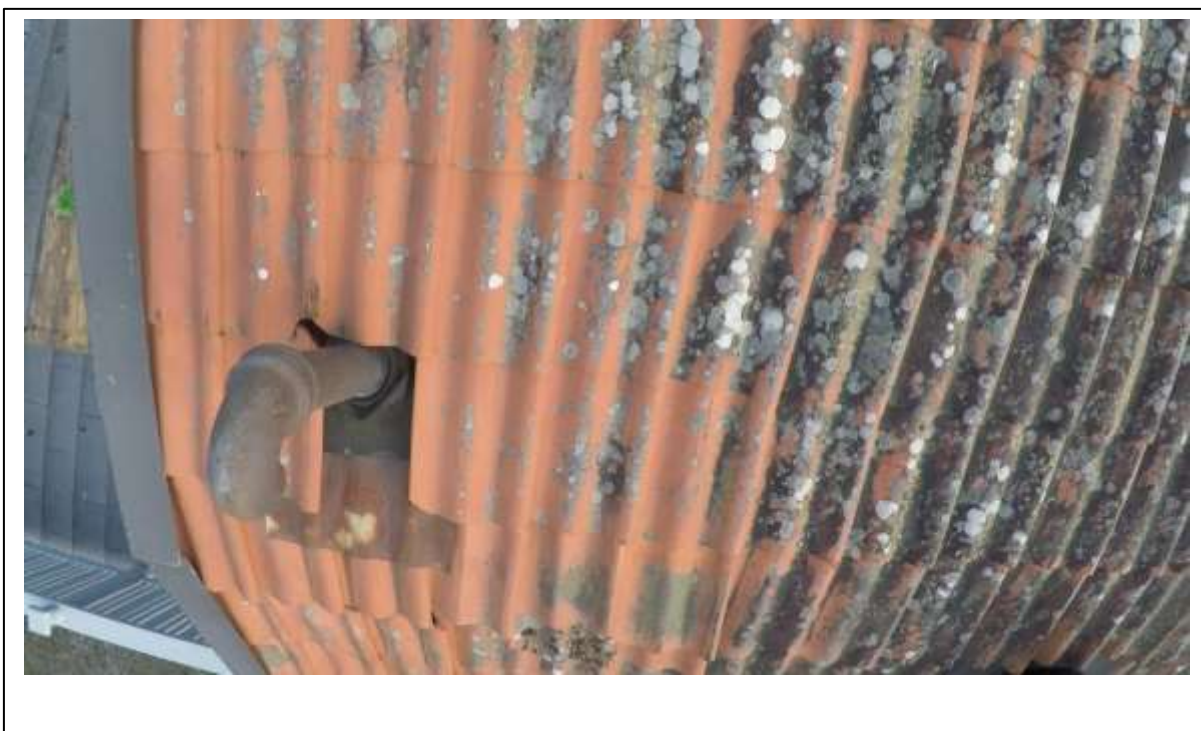
Figur 4, vy bild avluftningshuv.
