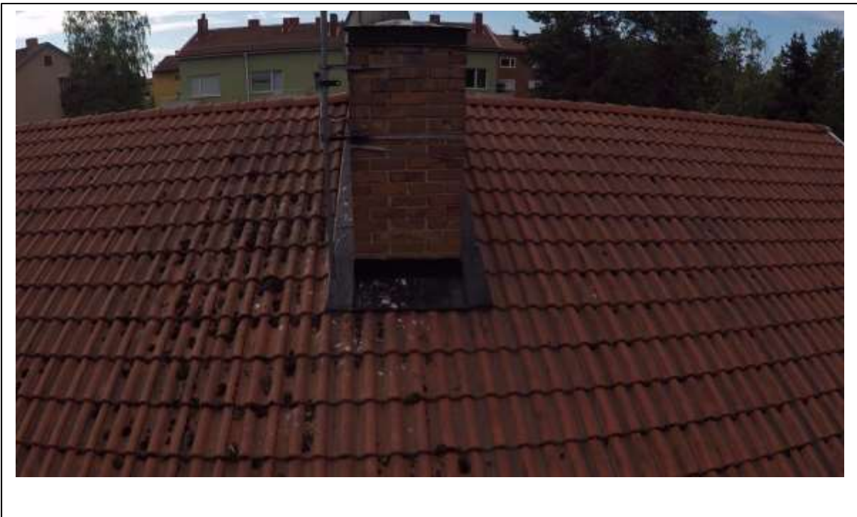
Figur 8, utvändig kontroll skorsten
