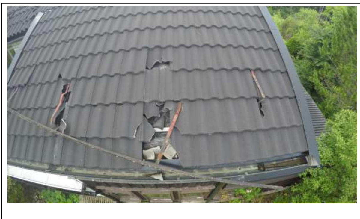
Figur 8, Deformerat snörasskydd.
